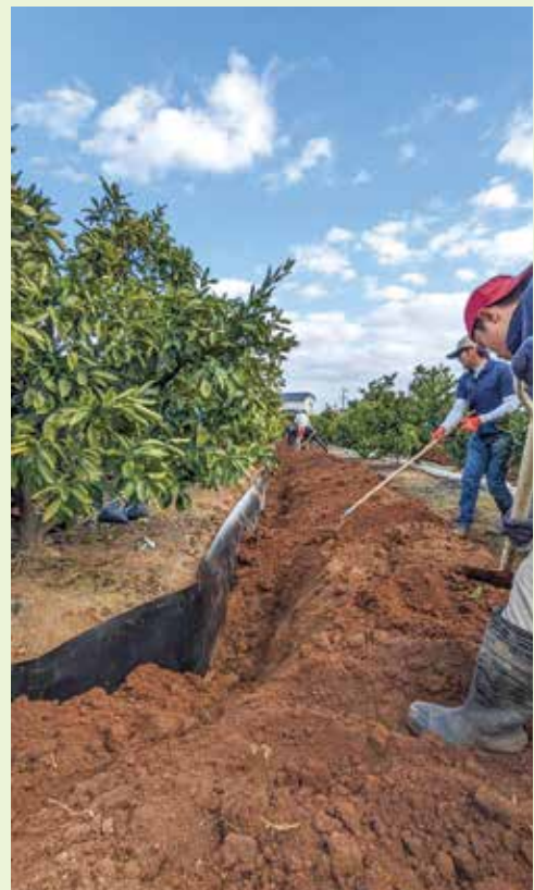
シールドディングシートを埋め込む部会役員とJA職員ら
